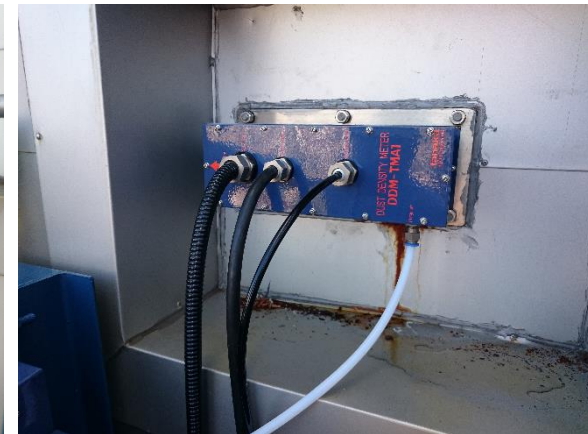
FGD outlet (white moisture gas) model:DDM-TMA1
