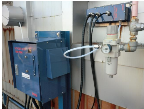
FGD outlet (white moisture gas) model:DDM-TMA1
