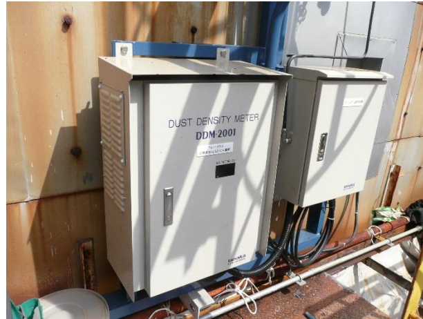
EP outlet (clear flue gas) model:DDM-2001
